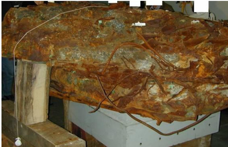
Eléments d'acier et de béton ayant fusionnés (l'abondance d'acier est indiquée par la rouille rougeâtre)
