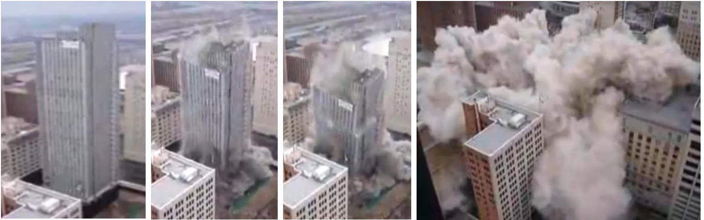
Démolition de la Tour Landmark (30 étages. Hauteur: 116m), Fort Worth, Texas -- 18 mars 2006 [vidéo]
