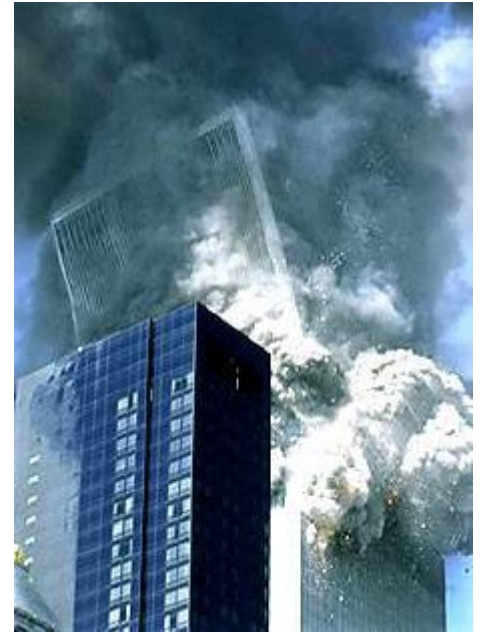
Basculement de la partie supérieure de la Tour Sud
