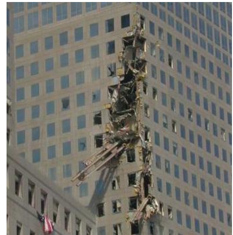
Poutre encastrée dans une tour située à plus de 100 m du WTC
