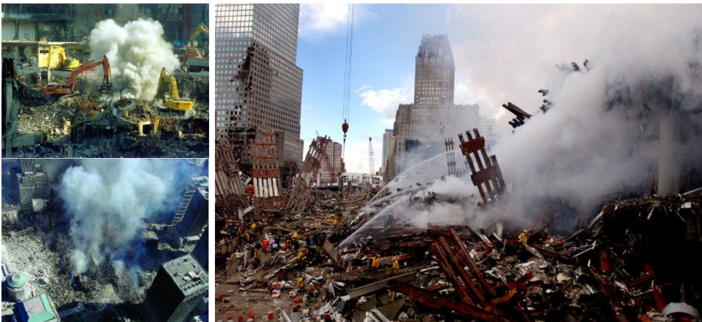
Épaisse fumée s'échappant des décombres jusqu'en décembre 2001 (notez les lances d'incendie en action sur l'image de droite)
